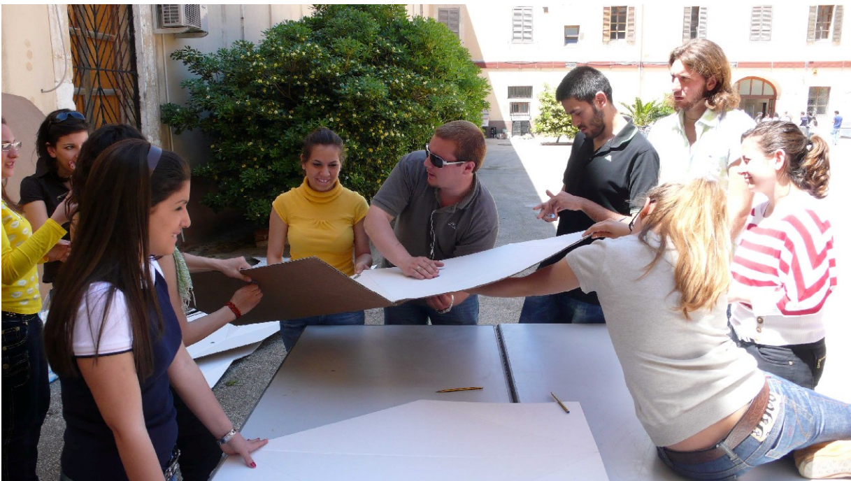
fig.2 Cortile della Facoltà di Architettura di Siracusa - Fasi di costruzione degli elementi componenti l'arco campione
